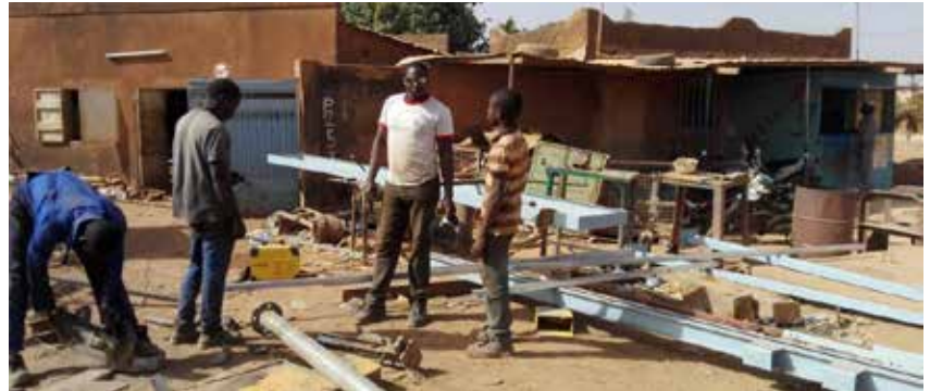
Montage eines Rahmengestells für Solarpaneele.
